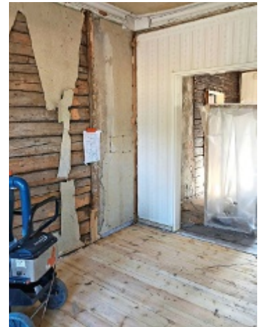
Purkutöissä paljastettiin alkuperäiset oviaukot. Kuva: Timo Tynkkynen
