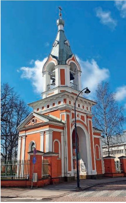
Kirkon rakennukset vievät aikamatkalle 1800-luvun Haminaan.
