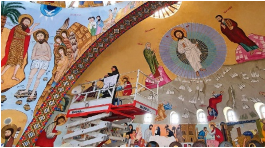
Sähkönosturin avulla maalarit ovat voineet maalata kupolin 12 metrin korkeudessa.
