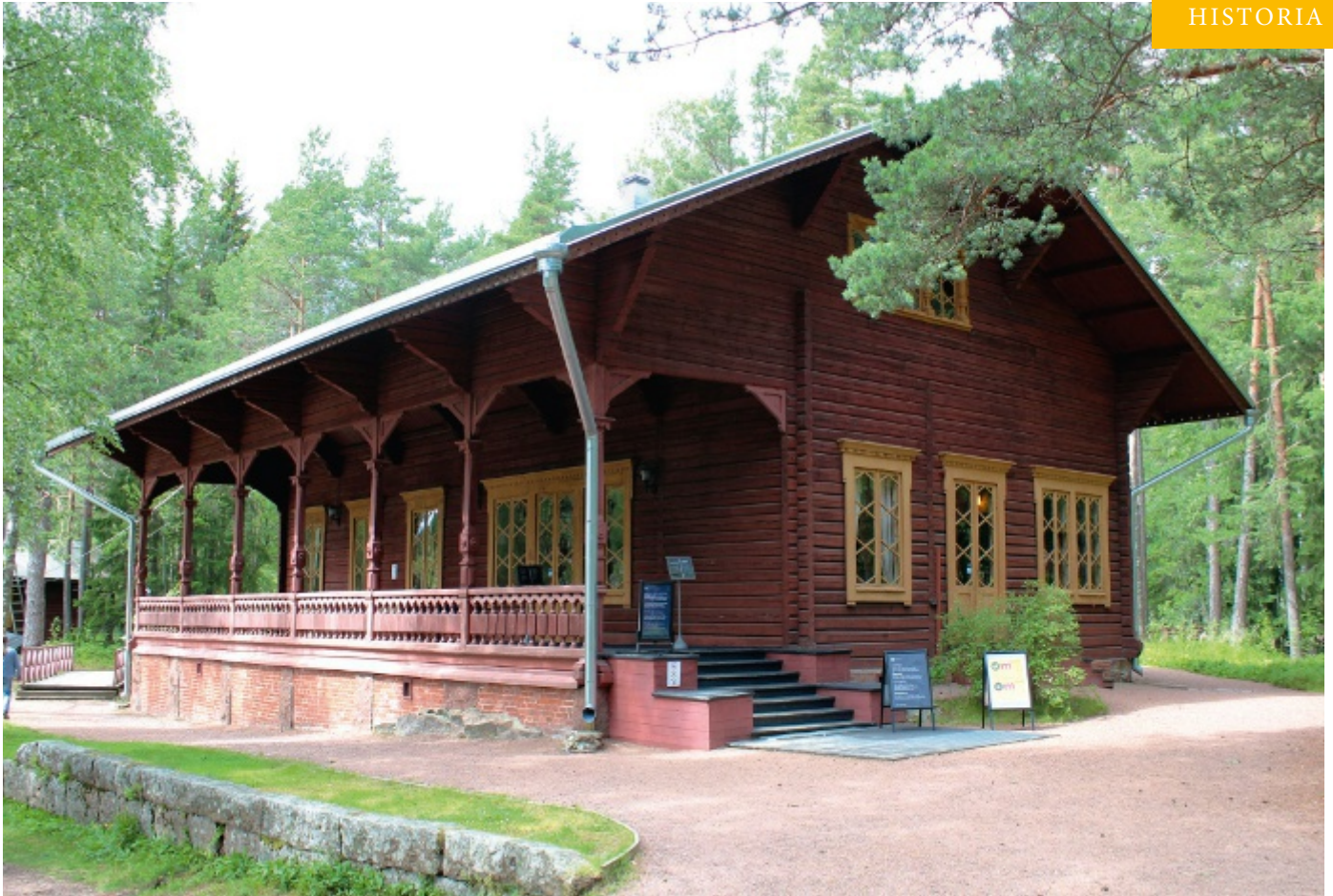
Kalastusmaja on vaatimaton nimitys muhkealle keisariajan hirsirakennukselle.
