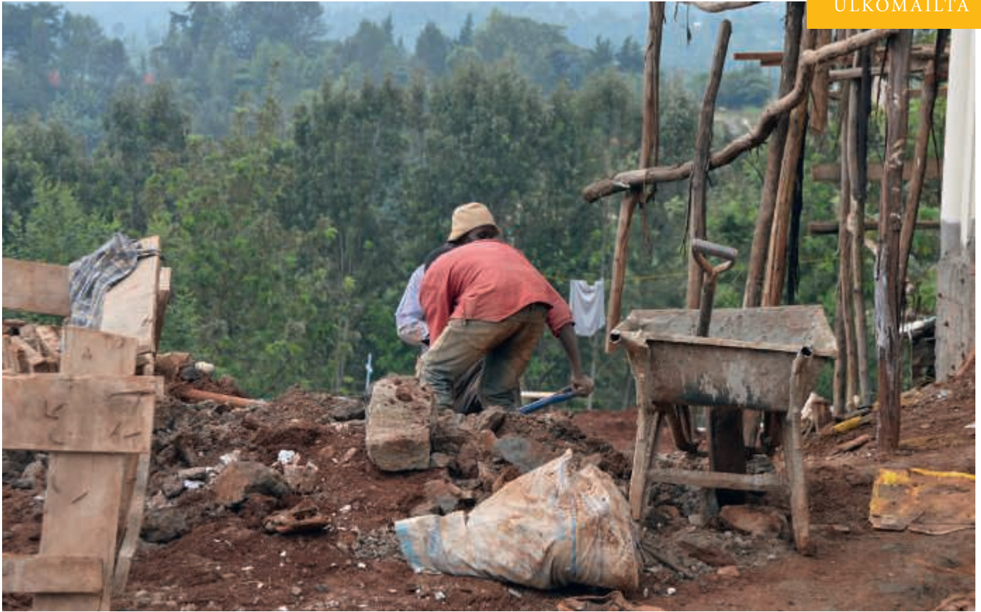
Filantropia tukee luostareiden rakentamista Keniassa. Kuva rakennustyömaalta kivijalan muuraamisesta.
