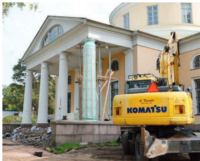
Syyskuun alussa Kotkan kirkon pohjoispuolen portaikkoo oli purettu. Yksi pylväistä on tuettu romahtamisvaaran vuoksi.
