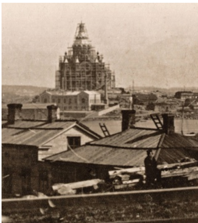
Ett foto taget av Carl Hårdh år 1866 visar att kyrkans yttre är så gott som färdigt, men att byggnadsställningarna ännu står kvar. En detalj av originalfoton.
