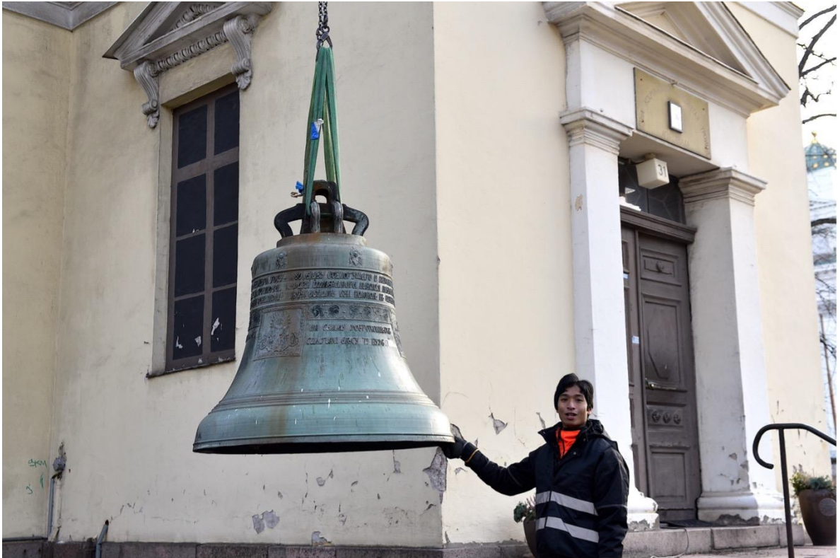
Pyhän Kolminaisuuden kirkon kellot nostettiin takaisin paikoilleen kunnostamisen jälkeen marraskuussa 2023. Kirkontorniteknikko Supavit Nummelin varmistaa, että kellojen nostaminen ja asentaminen sujuu kaikilta osin.
